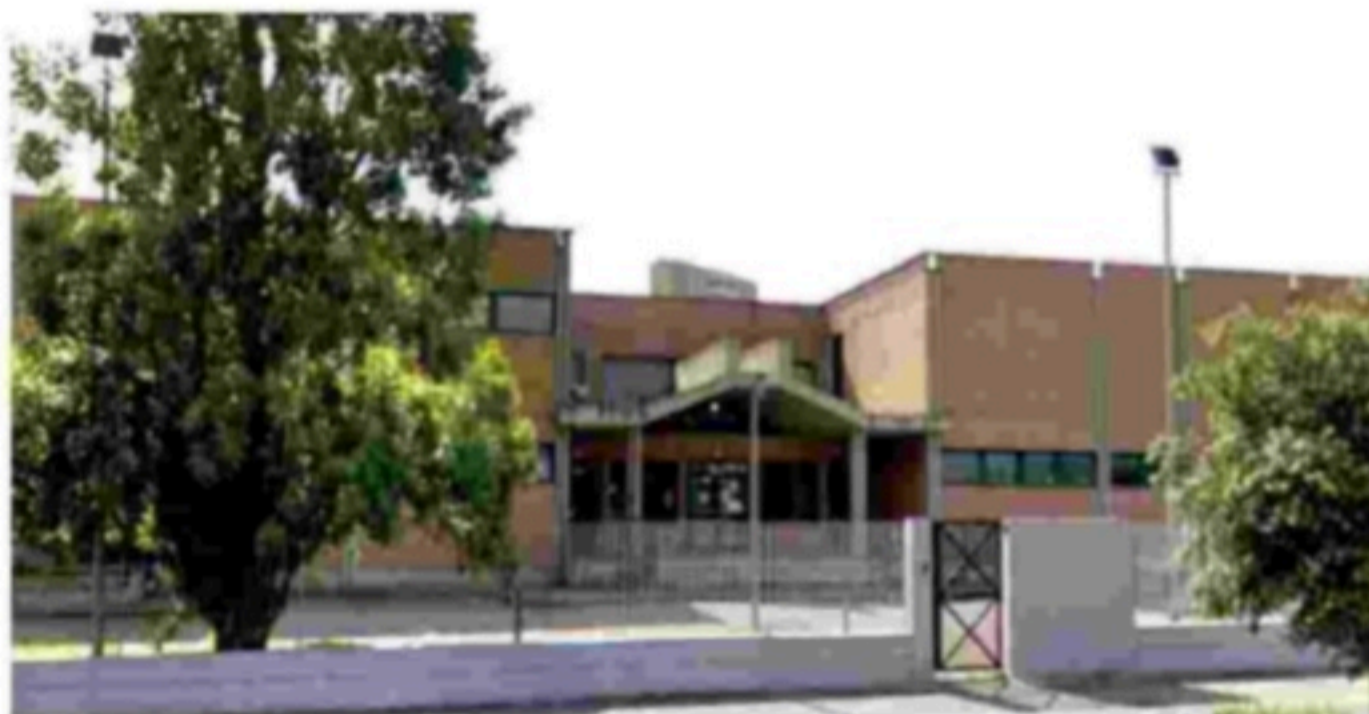
LE SCUOLE DI VIA BACHELET, VIA POLONIA E VIA CILEA. ALCUNI DEGLI ISTITUTI DOVE IL COMUNE DOVREBBE INTERVENIRE
